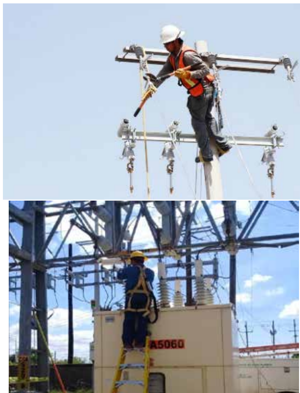
Fotografía: proceso de construcción de obras de electrificación
