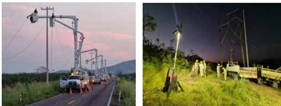
Trabajos de restablecimiento del suministro eléctrico por fenómenos naturales
