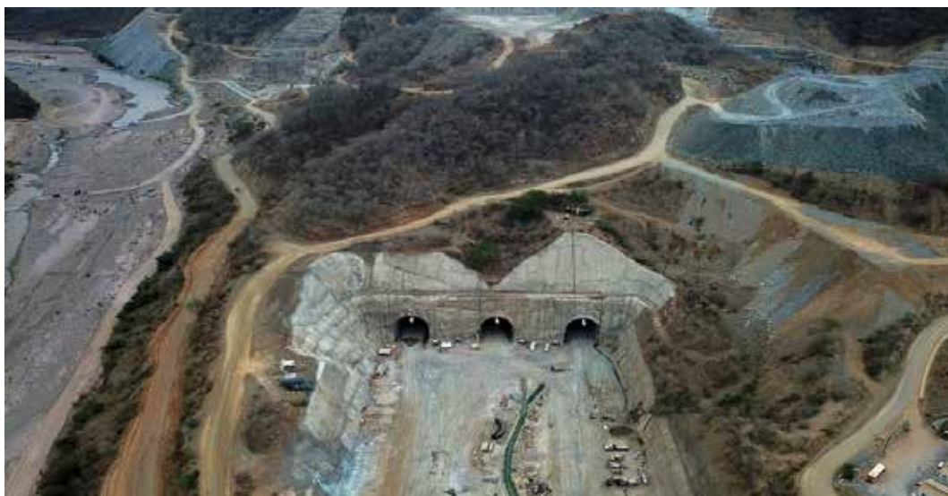
Fotografía: Portal de salida de los túneles de Desvío y Zona de Obras del E.H. de la Presa Sta. María.
