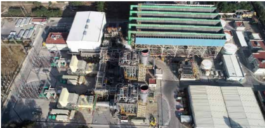
Fotografía: panorámica de la CCC Valle de México II
