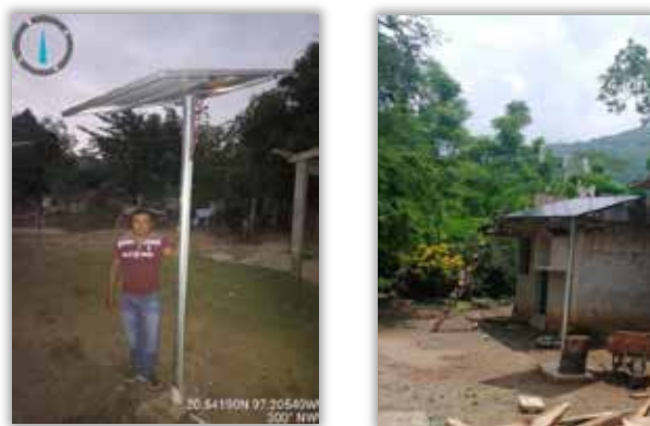
Electrificación de la localidad de Acuatla, municipio de Chapulhuacán en el estado de Hidalgo.
