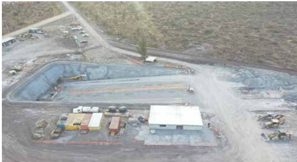
Fotografía: Portal de entrada de rampas de acceso y ventilación
