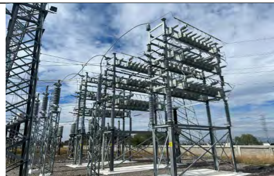
Ilustración 11. Banco de capacitores SE Querétaro Potencia
