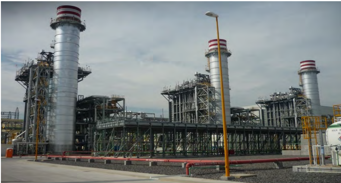
Fotografía: 264 CCC Centro
