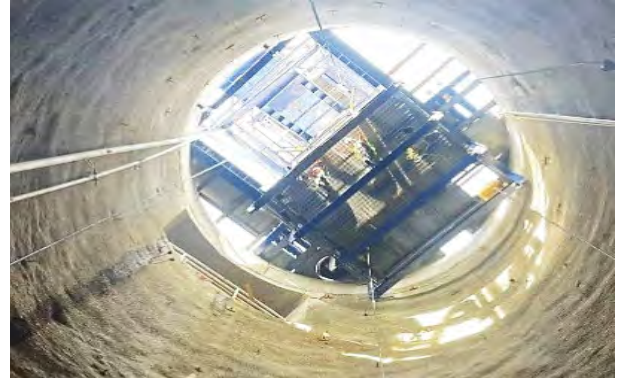
Fotografía: Vista interior de la lumbrera PCT-1
