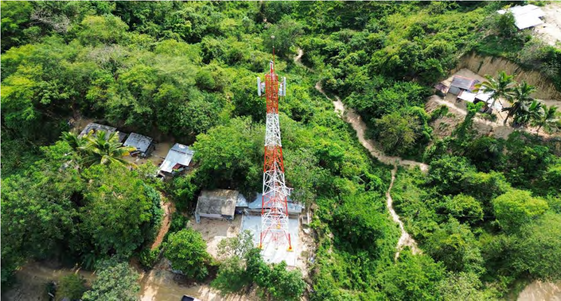
Fotografía: Torre instalada de telecomunicaciones en Santa María Tonameca, Oax.
