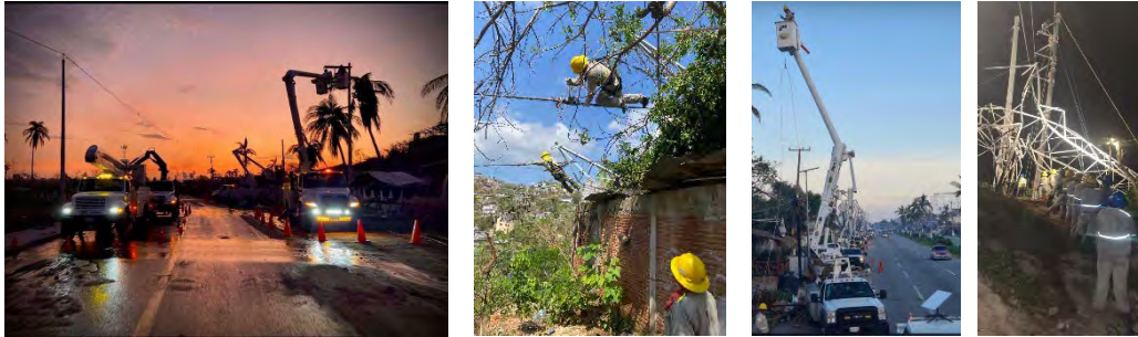
Trabajos de restablecimiento del suministro eléctrico por fenómenos naturales
