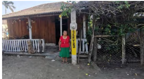
Electrificación de la localidad de Península de Atasta, municipio de San Antonio Cárdenas en el estado de Campeche.
