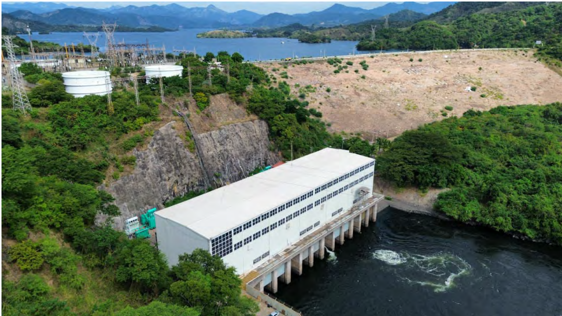
Central Hidroeléctrica La Villita
