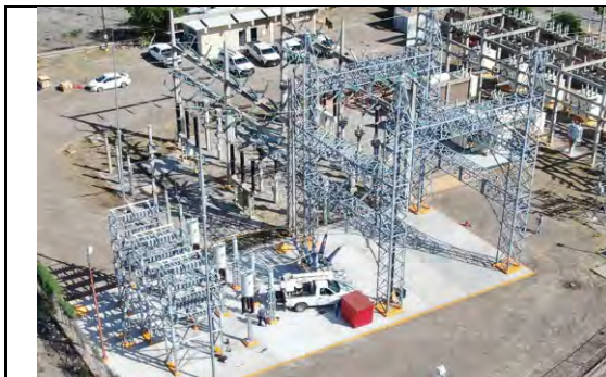
Ilustración 7. Montaje del banco de capacitores
