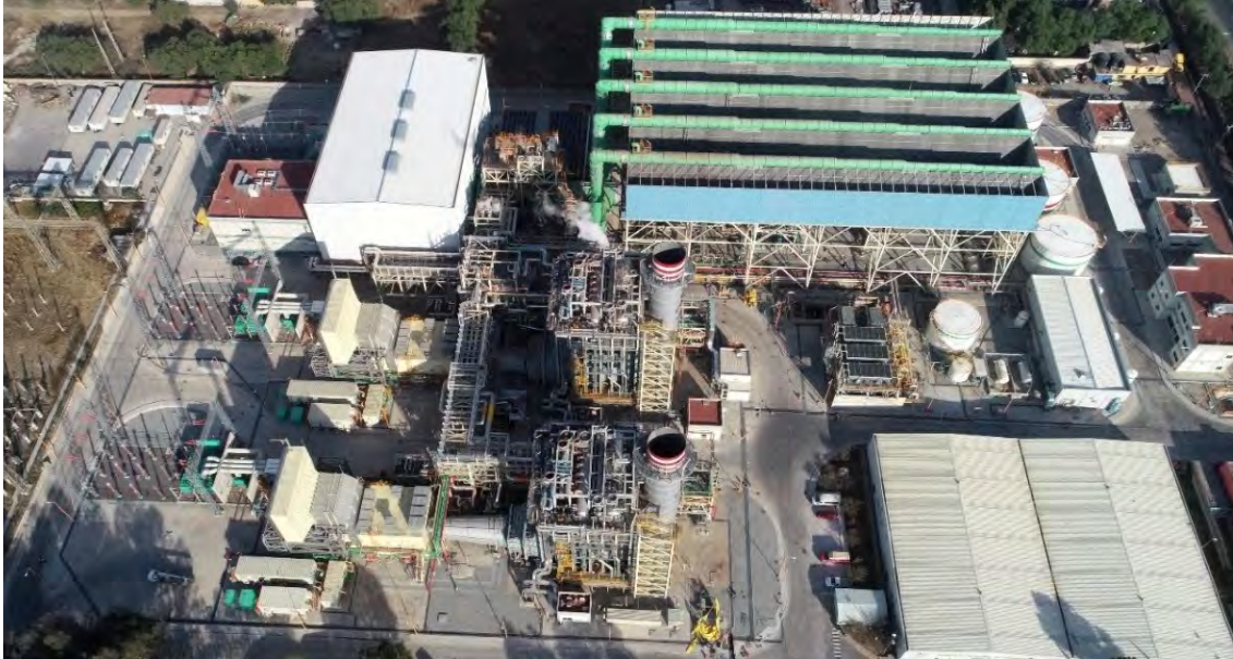
Fotografía: Panorámica de la CCC Valle de México II
