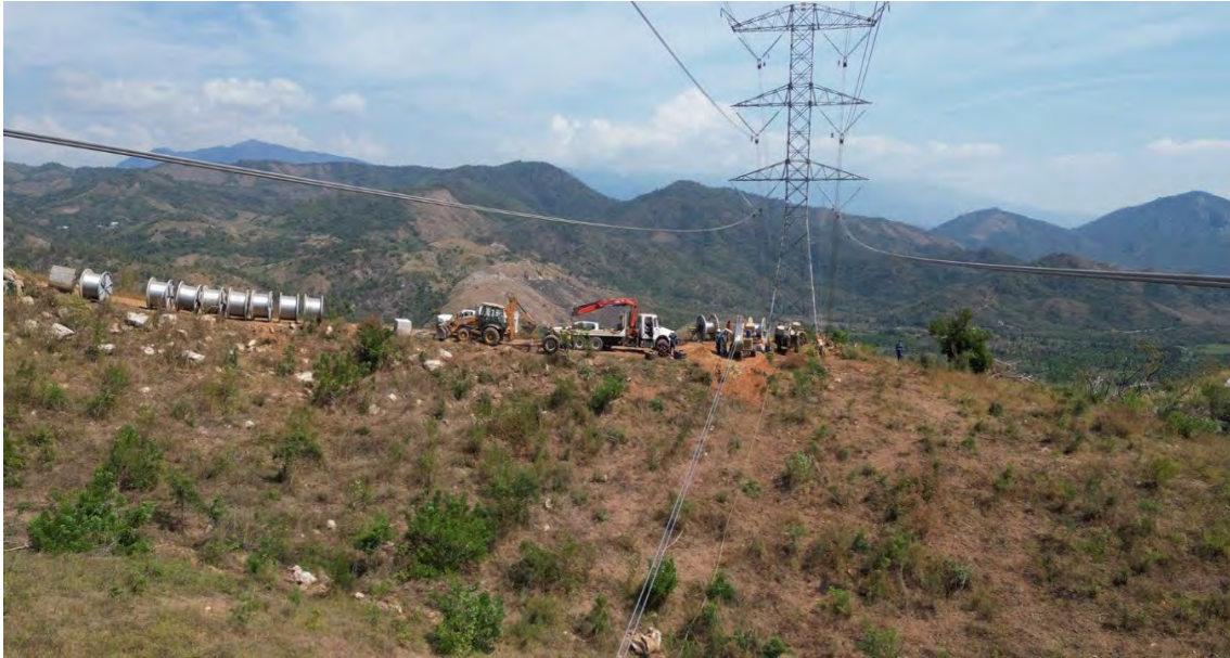
Fotografía: Tendido de cable conductor, operativo OTIS
