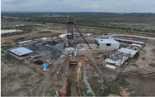
Fotografía: Vista general de la infraestructura para la excavación de la Lumbrera PCT-1
