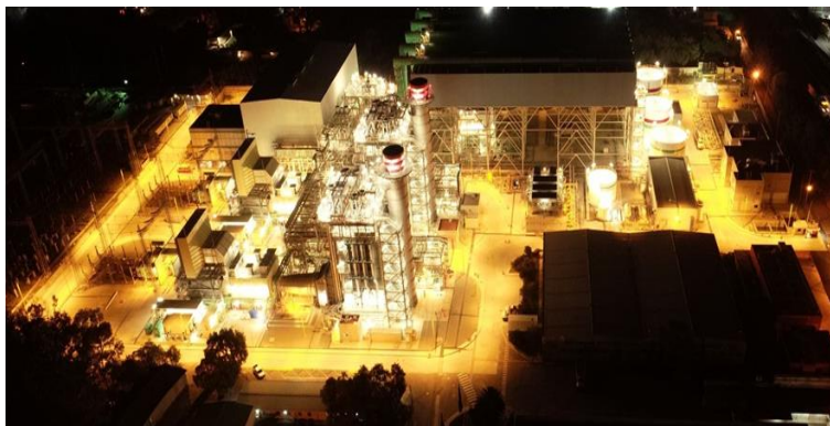
Vista aérea nocturna de la Central Ciclo Combinado Valle de México II.
