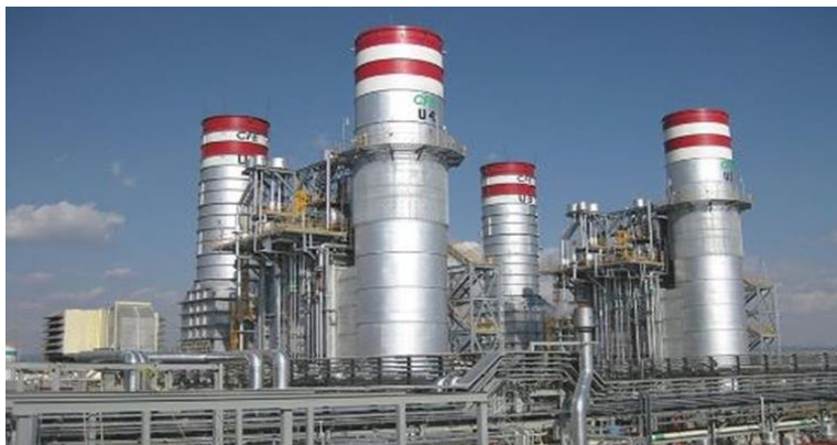
Vista aérea Central Ciclo Combinado Centro
