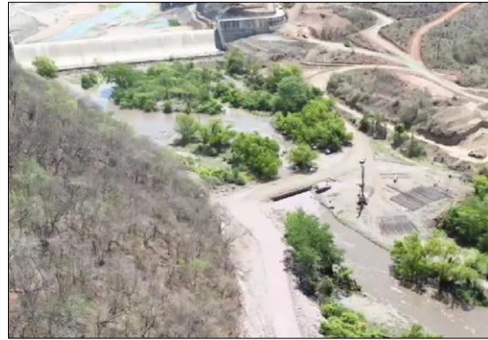
Imagen 2. Central Hidroeléctrica Amata
