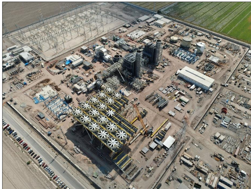
Imagen 6. Central Ciclo Combinado San Luis Río Colorado, avance a julio 2024.
