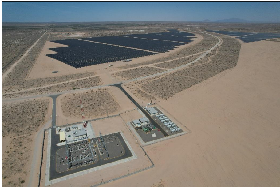
Imagen 7. Central Fotovoltaica Rafael Galván Maldonado (Puerto Peñasco), vista aérea de la primera etapa, en operación desde 2023.
